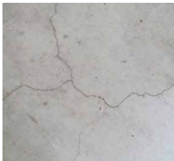
Desde há vários anos demonstrou-se que nas piscinas de betão se geram microfissuras devido a diferentes causas, como o envelhecimento da estrutura, a erosão ou os movimentos do terreno. Estas pequenas fissuras com menos de 3 mm não geram um problema estrutural, mas antes de estanquidade.
