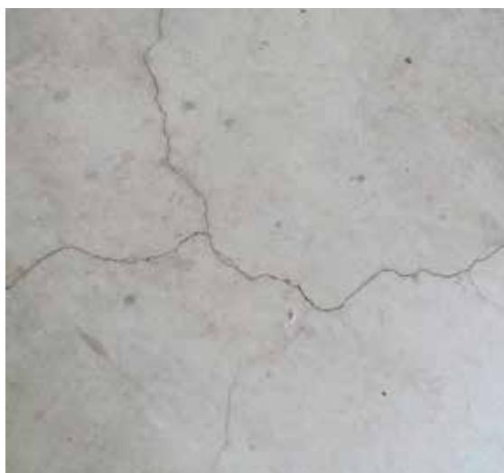
Per anni è stato dimostrato che le microfessure delle piscine in cemento si creano a seguito di diverse cause quali l'invecchiamento della struttura, l'erosione o il movimento del terreno. Le piccole fessure inferiori a 3 mm non generano un problema strutturale, ma hanno una tenuta stagna.
