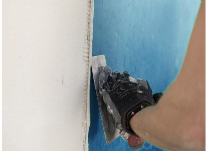
4. Los solapes se deben realizar utilizando el adhesivo bicomponente *Signapool X-COLL* en capa **muy fina** utilizando una llana de 2/3mm. En los accesorios y tubos colocaremos un parche de lámina sobre la lámina previamente adherida y el sellador, pegado también con *Signapool x-COLL*.
