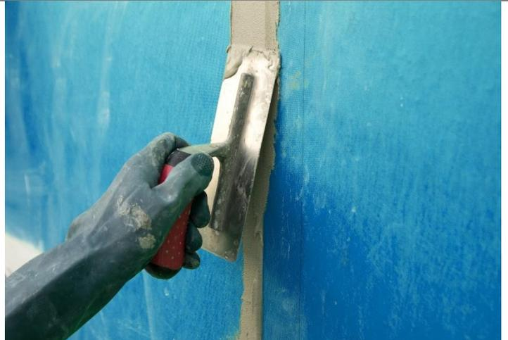
5. Las baldosas y mosaico de paredes se pueden colocar sin tiempos de espera después de haber finalizado el pegado y sellado de los solapes/accesorios. En el suelo, se debe esperar a que se seque el cemento cola bajo la lámina; de lo contrario, la circulación sobre el suelo podría provocar desigualdades.
